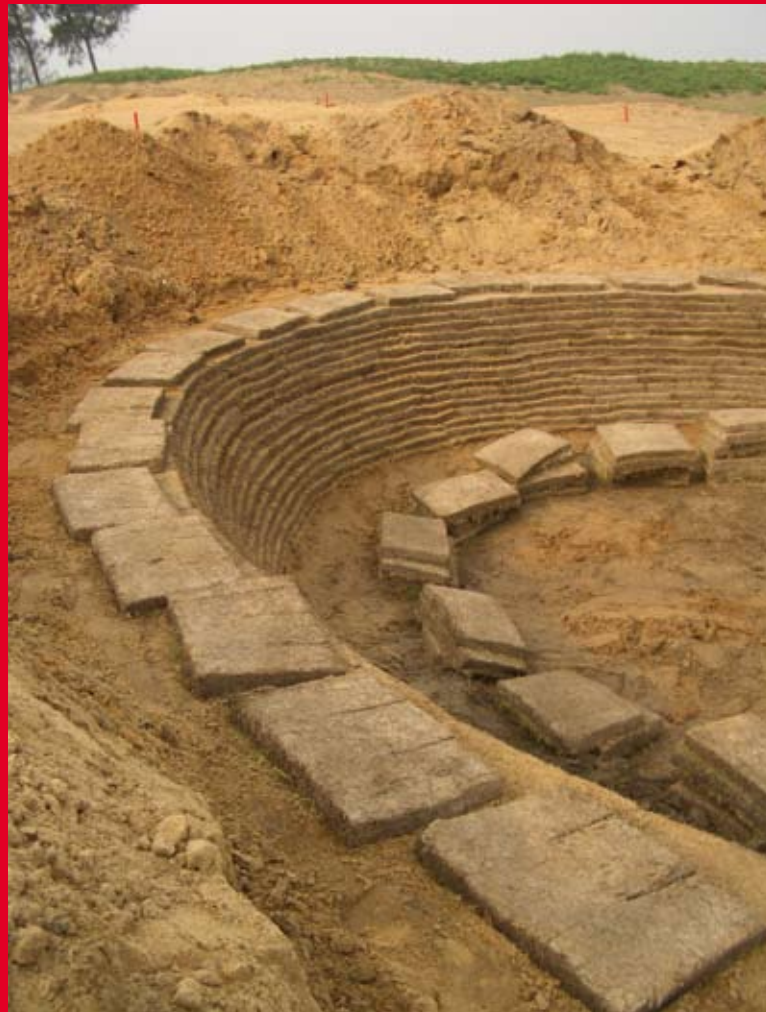
Constructie van een 'revetted' bunker
