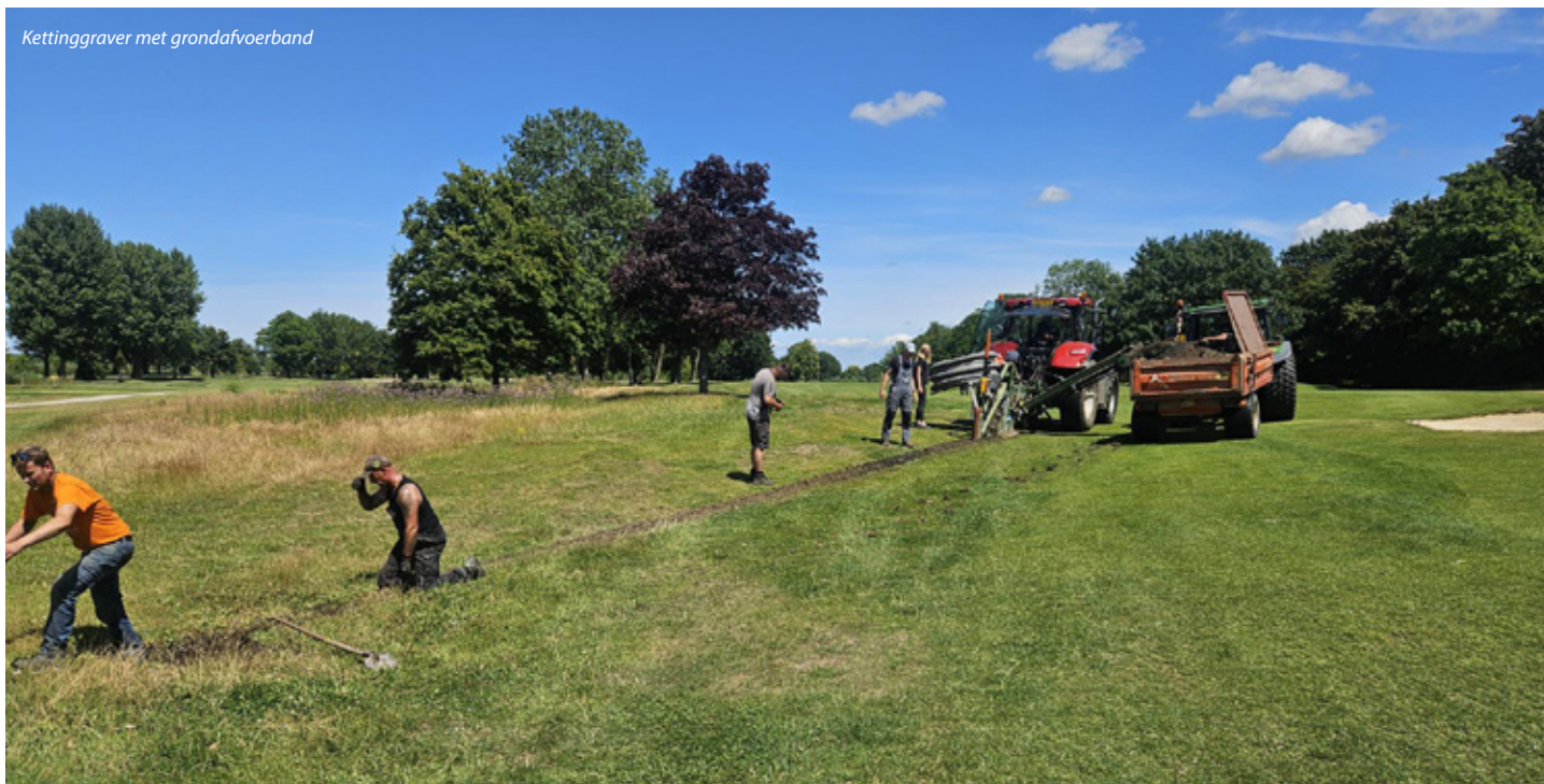
Aanleg nieuw hoofddrainagenetwerk
